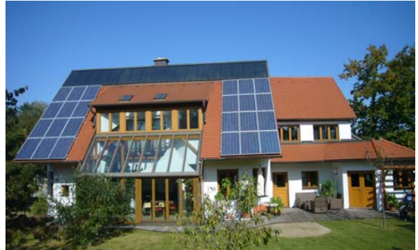
EFH- und Bürohaus mit Photovoltaik und Solarthermie
